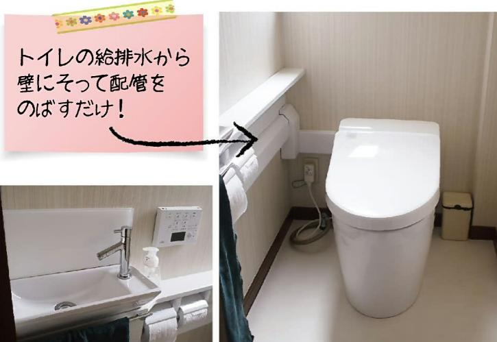
すっきりとしたタンクレストイレにしたいけど、手洗い器も欲しい。そんなO様のお声からTOTOの「ネオレスト（ワンデーリモデル）」に。トイレの給排水を分歧させ、壁に沿って配管をのばして手洗い場を設置できるので、工事時間も費用も抑えられます。
