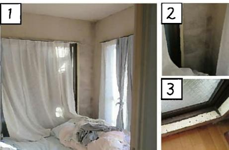
写真1: 気密性の高いマンションであることに加え、窓の多い角部屋で断熱も不十分という条件が重なり、結露が大発生。換気を十分に行えずにいたら部屋中カビだらけになってしまったそう。写真2・3: 壁だけでなく、窓枠や床にまでカビが発生。
