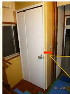
黄色い部分が壁紙を貼る前の新設した壁。トイレに20センチ奥行ができました。
