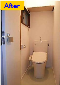
After K様邸に設置したのは「TOTOピュアレストQR」 今までのトイレと比較すると水の使用量は1/4とかなりの節水力です。 ご家族の多いご家庭には特におすすめです！
