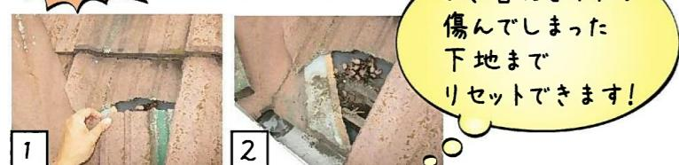
写真1：瓦屋根は築40年程で問題が発生しやすくなります。こちらでは自然劣化により瓦が割れてしまっていました。写真2：割れた瓦の下に雨水やゴミが入り、下地や軒天が腐って崩れそうな状態に。この場合は下地から補修する葺き替えがベストです。
