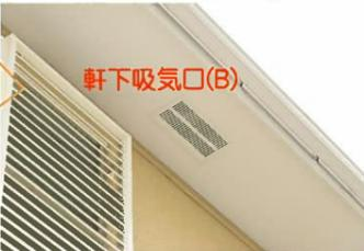
屋根裏・天井裏には換気口も無く、熱がこもっていました。リフォームでは屋根に棟換気(A)軒下に吸気口(B)をつくり、屋根裏に熱がこもらないように、空気の流れをスムーズにする工事も行い、天井裏の環境を一年中快適に保てるようにしました。
