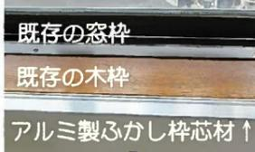
二重窓を設置するには、最低限の窓枠の奥行きが必要です。これを必要寸法と言いますが、必要寸法が不足している場合には、**ふかし枠**という部材を取付けて奥行きを調整します。
