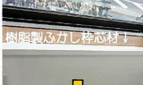
これで、殆どの窓枠に二重窓が設置出来るようになります。キタセツの窓枠も必要寸法が不足していた為、ふかし枠（アルミ製の芯材の上から樹脂製の芯材をかぶせる）を取付けました。
