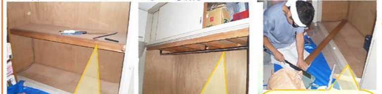
押入れの中段を撤去する工事の様子
