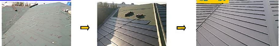
屋根も傷みが激しかったので「かぶせ葺き」という施工法でリニューアルしました。元の屋根に断熱性能の高い「横暖ルーフα」という屋根材をかぶせ、新築同様の仕上がりです！
